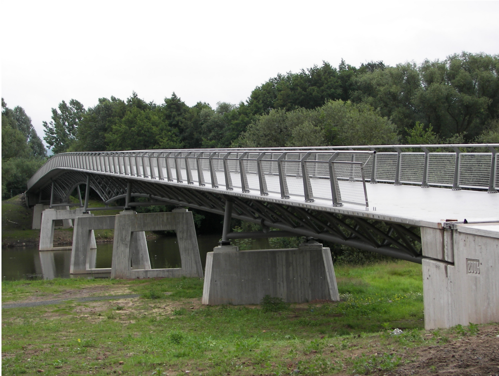
Abbildung 1.2: Die aus ultrahochfestem Beton gefertigte Gärtnerplatzbrücke in Kassel.
